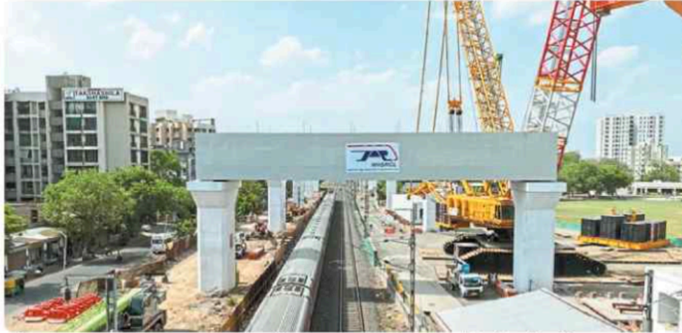
मणिनगर-अहमदाबाद रेलखंड पर बुलेट ट्रेन प्रोजेक्ट पर 1360 टन वजन का पोर्टल बीम लॉन्च किया गया।
