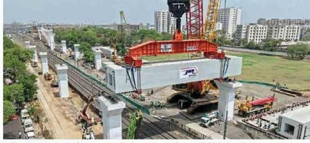
मणी नगर (गुजरात) : मुंबई-अहमदाबाद बुलेट ट्रेन प्रकल्पांतर्गत बुधवारी येथे रेल्वेमार्गावर महाकाय असा १,३६० टनांचा पोर्टल बीम बसविण्यात आला.
