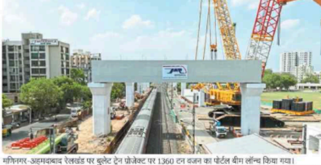
मणिनगर-अहमदाबाद रेलखंड पर बुलेट ट्रेन प्रोजेक्ट पर 1360 टन वजन का पोर्टल बीम लॉन्च किया गया।
